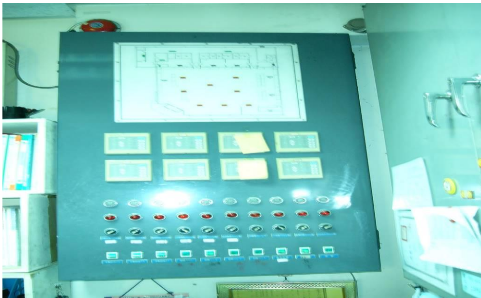
圖 6.3-1 高低壓配電系統
