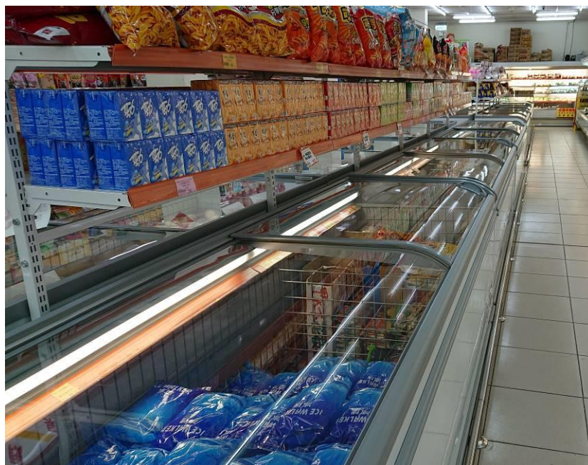
圖 6.3-7 採用拉門密閉式冷凍冷藏櫃可減少冷能散失而節能
